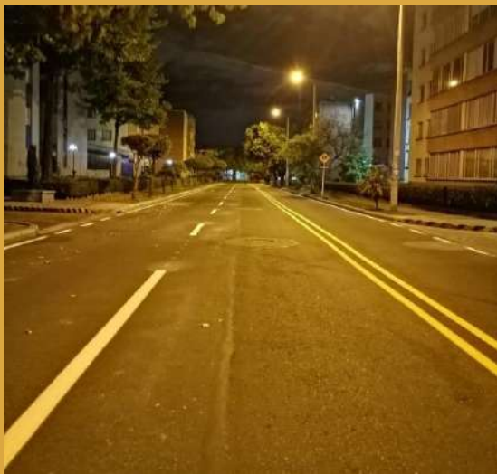
DEMARCACIÓN VIAL CON PINTURA ACRÍLICA – CIV 14000058, 14000039 Y 14001714
