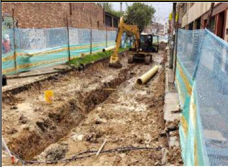
REPOSICION DE TUBERIA RED PRINCIPAL DE ALCANTARILLADO
