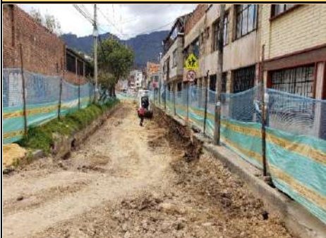
REPOSICION DE TUBERIA RED PRINCIPAL DE ALCANTARILLADO
