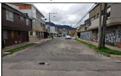
ESTADO INICIAL DE LA VIA
