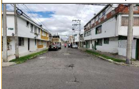
ESTADO INICIAL DE LA VIA
