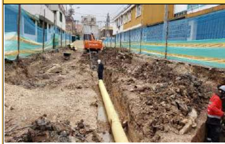
REPOSICION DE TUBERIA RED PRINCIPAL DE ALCANTARILLADO
