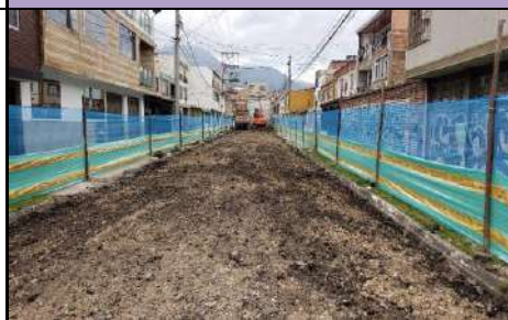
DEMOLICION DE CARPETA ASFALTICA
