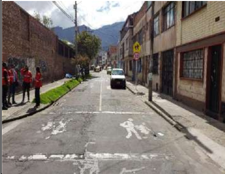
ESTADO INICIAL DE LA VIA
