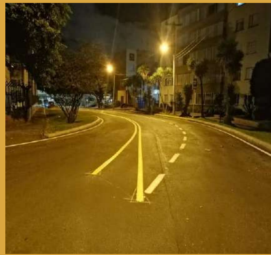
DEMARCACIÓN VIAL CON PINTURA ACRÍLICA – CIV 14000058, 14000039 Y 14001714
