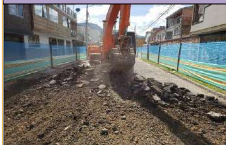
DEMOLICION DE CARPETA ASFALTICA
