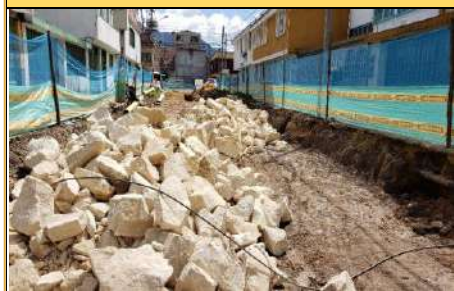
INSTALACION DE RAJON
