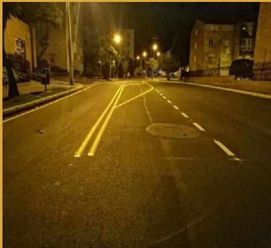
DEMARCACIÓN VIAL CON PINTURA ACRÍLICA – CIV 14000058, 14000039 Y 14001714
