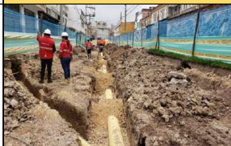
REPOSICION DE TUBERIA RED PRINCIPAL DE ALCANTARILLADO
