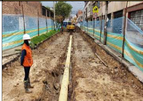
REPOSICION DE TUBERIA RED PRINCIPAL DE ALCANTARILLADO
